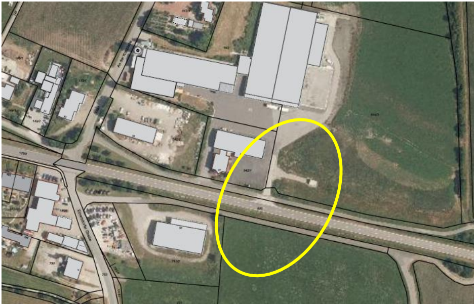
Luftbild mit hergestellter provisorischer Zufahrt von der Staatsstraße
